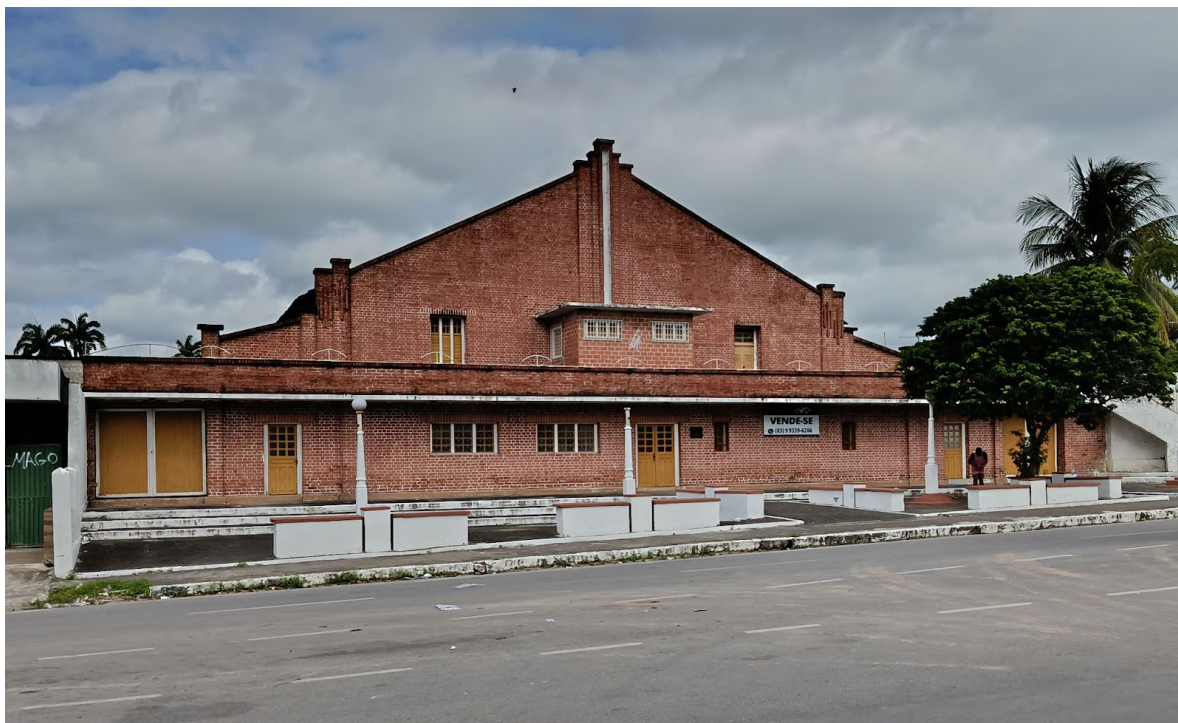
Figura 02 - Edificação - Cine Teatro Orion
