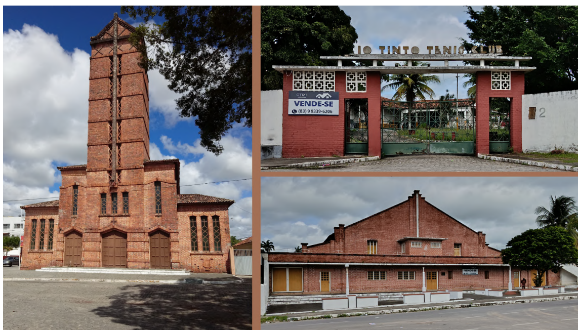
Figura 06 - Visita às edificações da cidade de Rio Tinto
