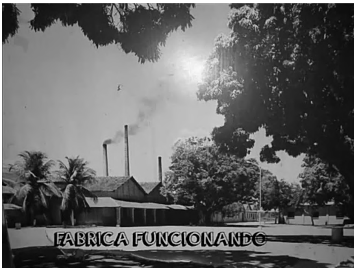
Figura 01 - Fábrica em Funcionamento
