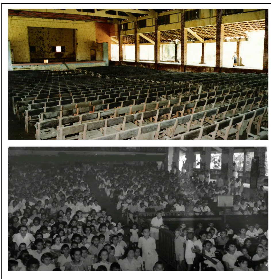
Figura 7: Área interna do Cine Orion com duas fileiras de cadeiras de concreto e madeira; área interna com plateia
