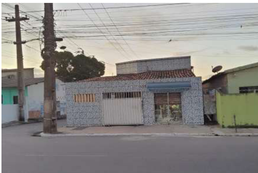
Figura 6 - Vista de frente do imóvel, (2026).
