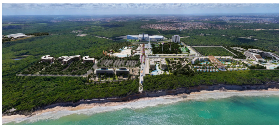
FIGURA 9: CONSTRUÇÃO DO POLO TURÍSTICO CABO BRANCO
