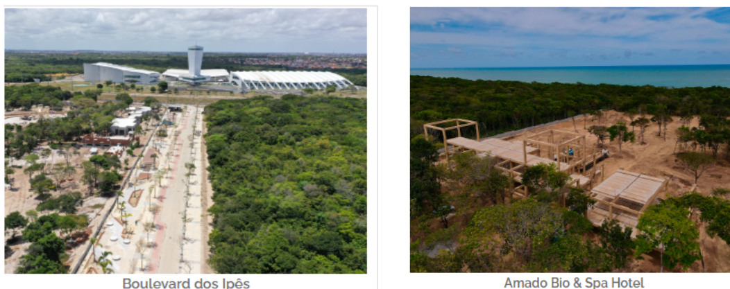
FIGURA 11: OBRAS EM ANDAMENTO: BOULEVARD DOS IPÊS E AMADO BIO & SPA HOTEL
