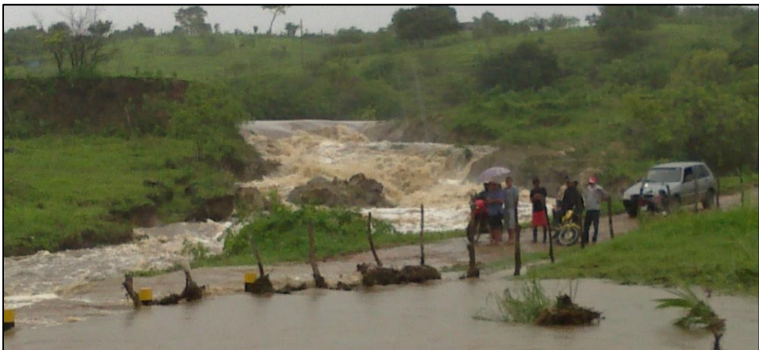
Figura 21. Sangradouro da Barragem Cuité
