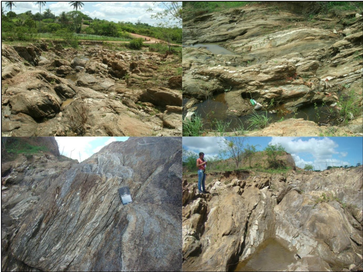
Figura 22. Afloramento de rochas na barragem de Cuité.
