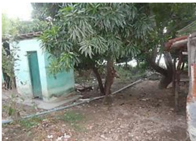
Figura 5. Banheiro sem saneamento adequado do esgoto. Imagem. (Clovesbel Paulino, 2013)
