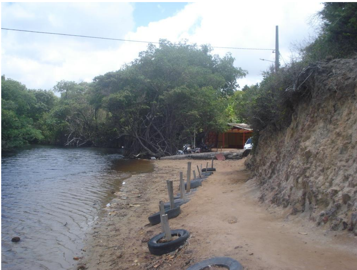
Foto 07. Construção equivocada da barreira de pneus não impediu a queda dos sedimentos da falésia (Foto: Dennys Bizerra, março de 2013).
