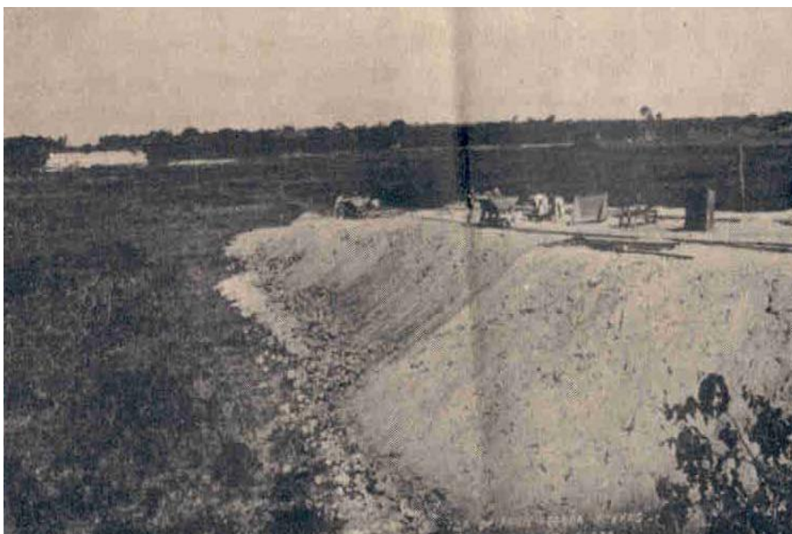
Figura 09. Aterro das margens do Rio Jaguaribe durante as obras da Avenida Epitácio Pessoa em 1933. Foto: Acervo Jornal O Norte 1988.
