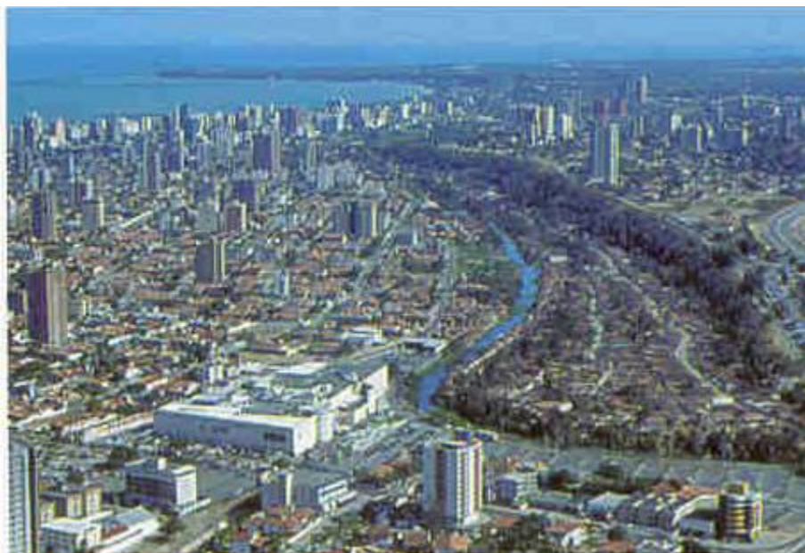
Figura 29. Vista aérea do Rio Jaguaribe com o “Bairro São José” criado por Lúcia Braga em 1983. Além das pressões da especulação imobiliária que verticalizam o bairro de Manaíra – à esquerda – o Manaíra Shopping – principal conjunto horizontalizado em baixo e à esquerda da Foto – vem contribuindo para aumentar a poluição e o estreitamento do seu leito.
