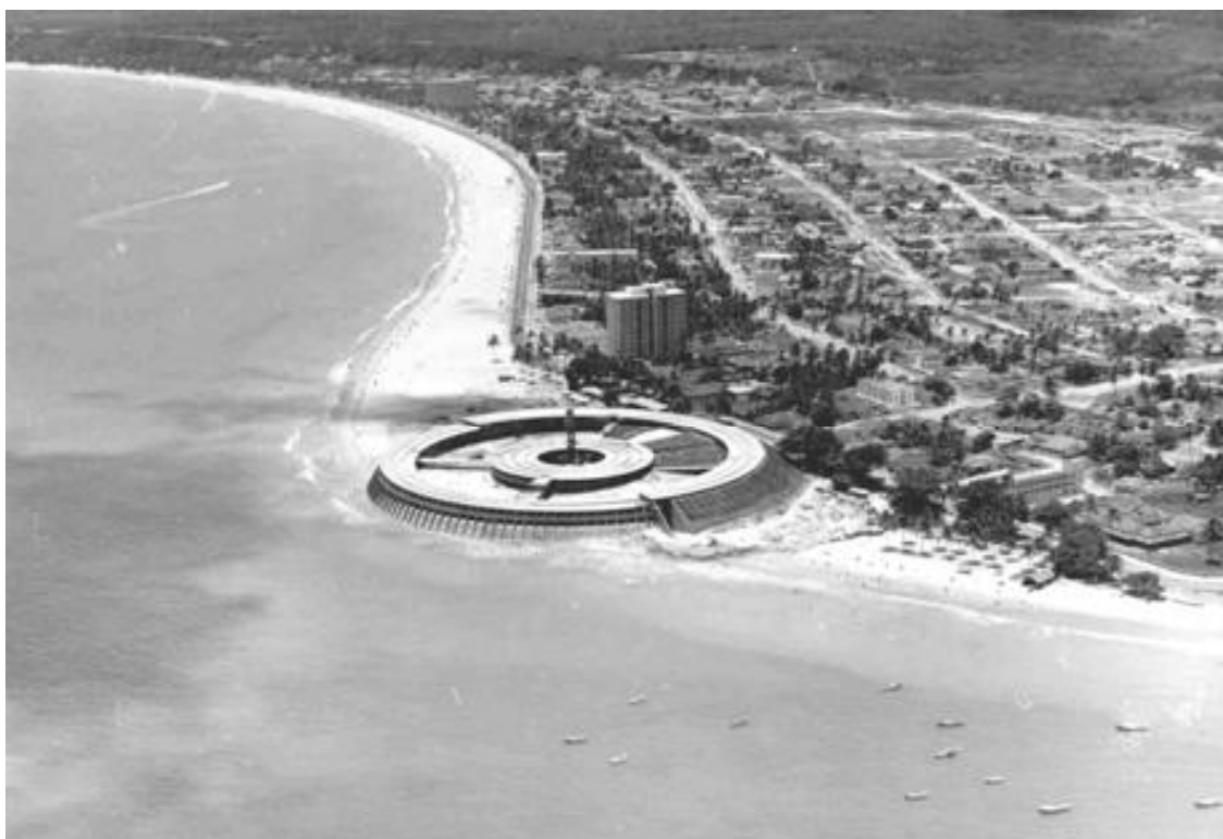
Figuras 17 e 18. Na primeira imagem, a Praia de Tambaú em 1968 ainda sem a construção do hotel, com o seu pontal ao fundo coberto de coqueiros. Em 1974, já ocupado pelo hotel, o pontal perdeu a maior parte de sua vegetação. Os problemas viários até hoje não foram bem solucionados, provocando impactos em sua vizinhança.
