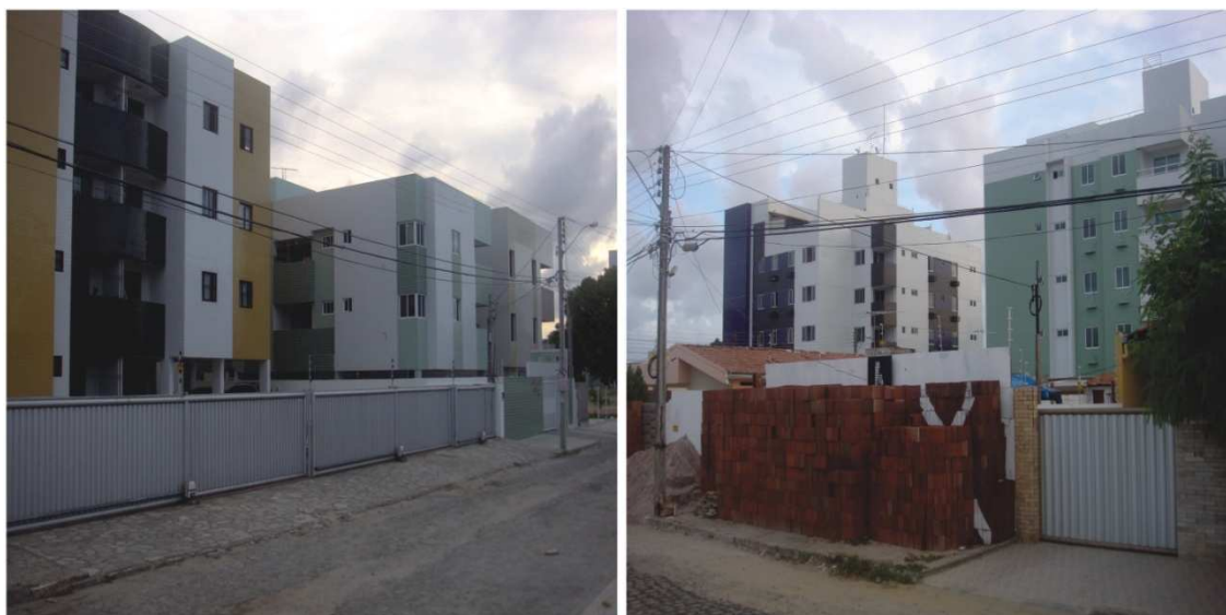
Foto 6: Alguns pequenos prédios residenciais em construção e outros já construídos, distribuídos por entre os bairros Bancários, Água Fria e Jardim Cidade Universitária.
