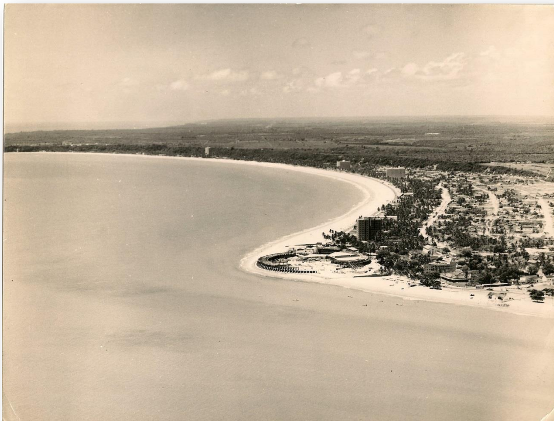
Figura 5 – Vista panorâmica da obra de construção do Tropical Hotel Tambaú por volta da década de 1970
