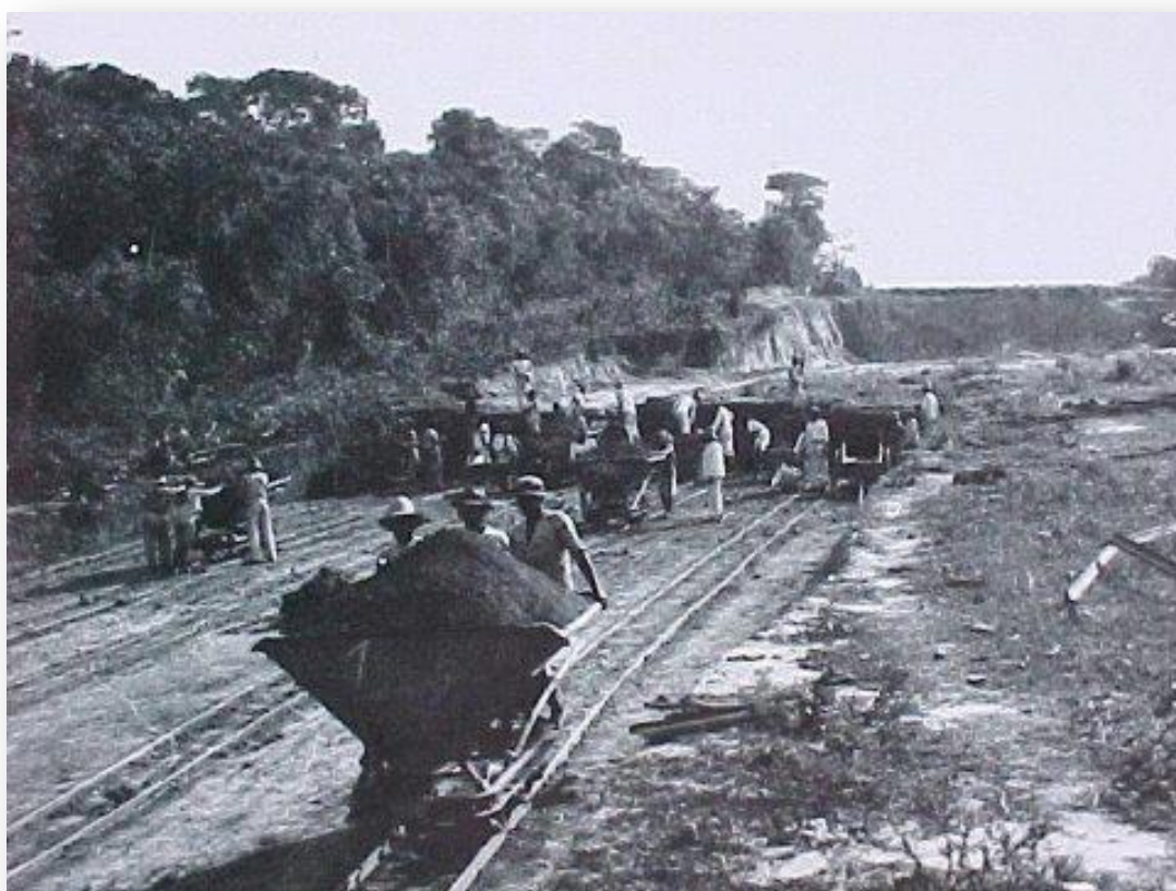
Figura 2 – Obra de ampliação da Av. Epitácio Pessoa em direção à praia.
