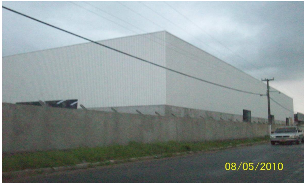
Figura 7 - Fonte: Joelma Silva – Construção de um galpão que servirá como fábrica
