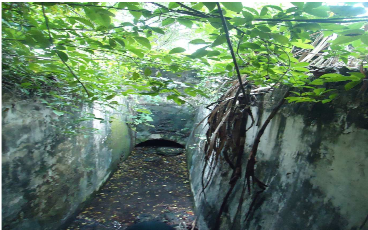
Foto 1 – Ruínas do antigo Engenho Gargaú. No local encontram-se somente algumas paredes do antigo engenho e esse pequeno Túnel, cuja origem e função não são bem esclarecidas. Fonte: Acervo do autor. (Data: 12/07/2013).
