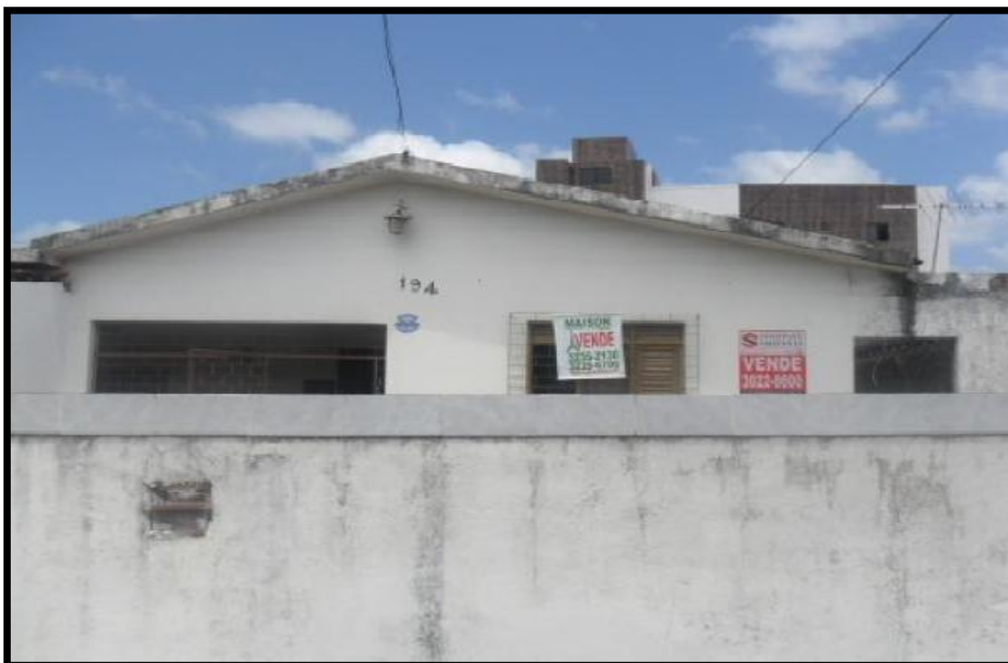
Casa de Conjunto no Bairro José Américo, Rua Benicio Gomes De Araújo. Fonte: Francisco Filho, Data: 10/06/2013.
