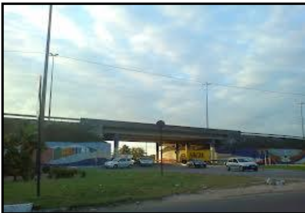
Figura 10: BR-230 Viaduto Cristo Redentor, ou “Sonrisal” João Pessoa Paraíba. Fonte: www.panoramio.com (© Todos os direitos reservados por Been Bem)
