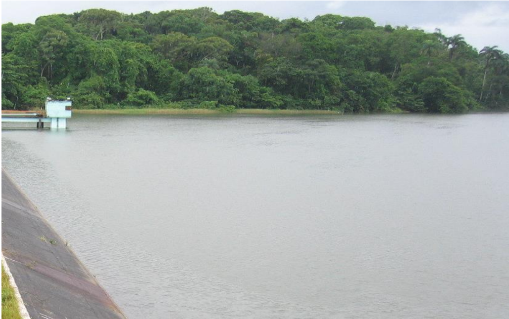
Figura 2- Reservatório da Bacia Marés.
