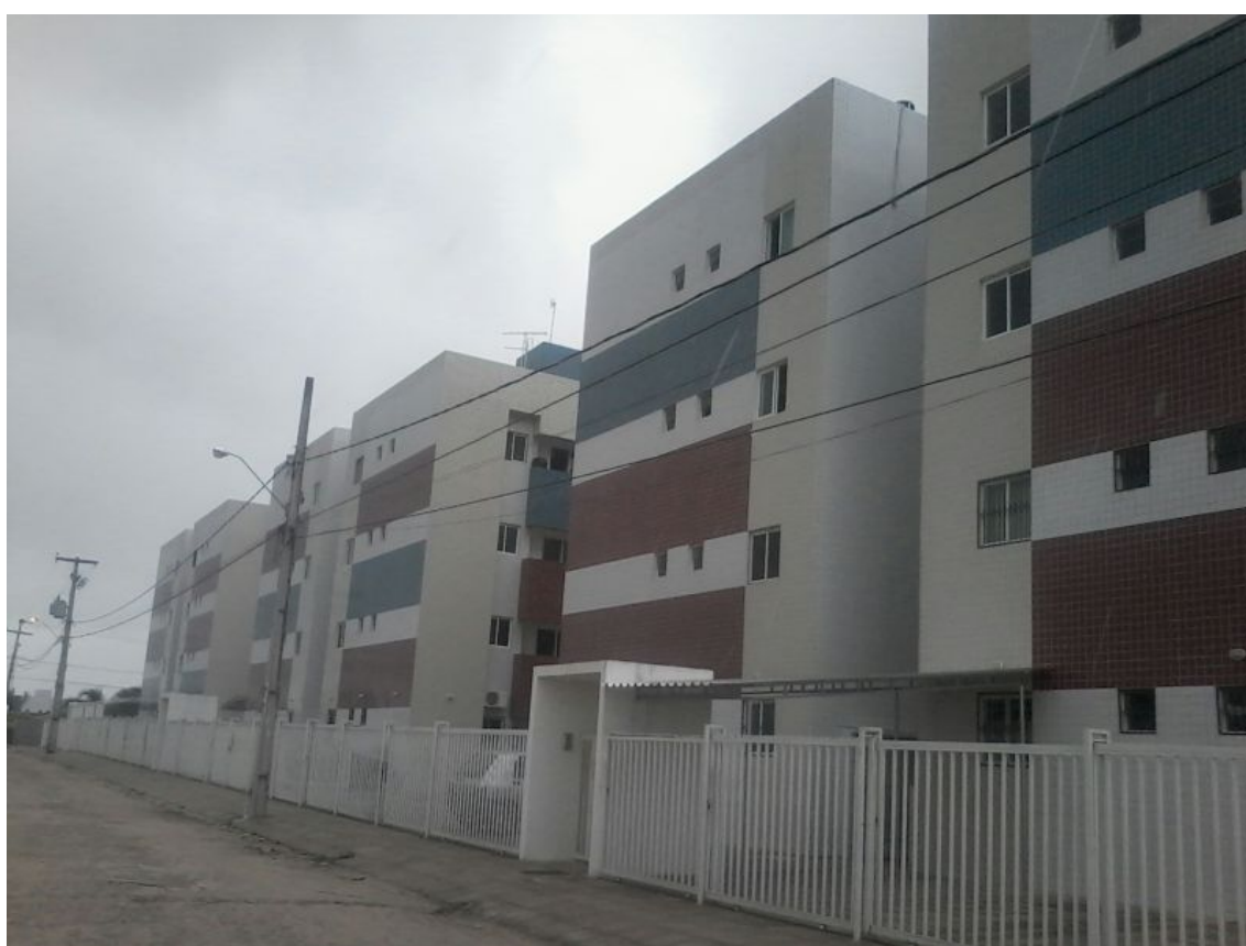
Figura 14: Edifícios residenciais no loteamento parque do sol Fonte: foto do autor, junho de 2014
