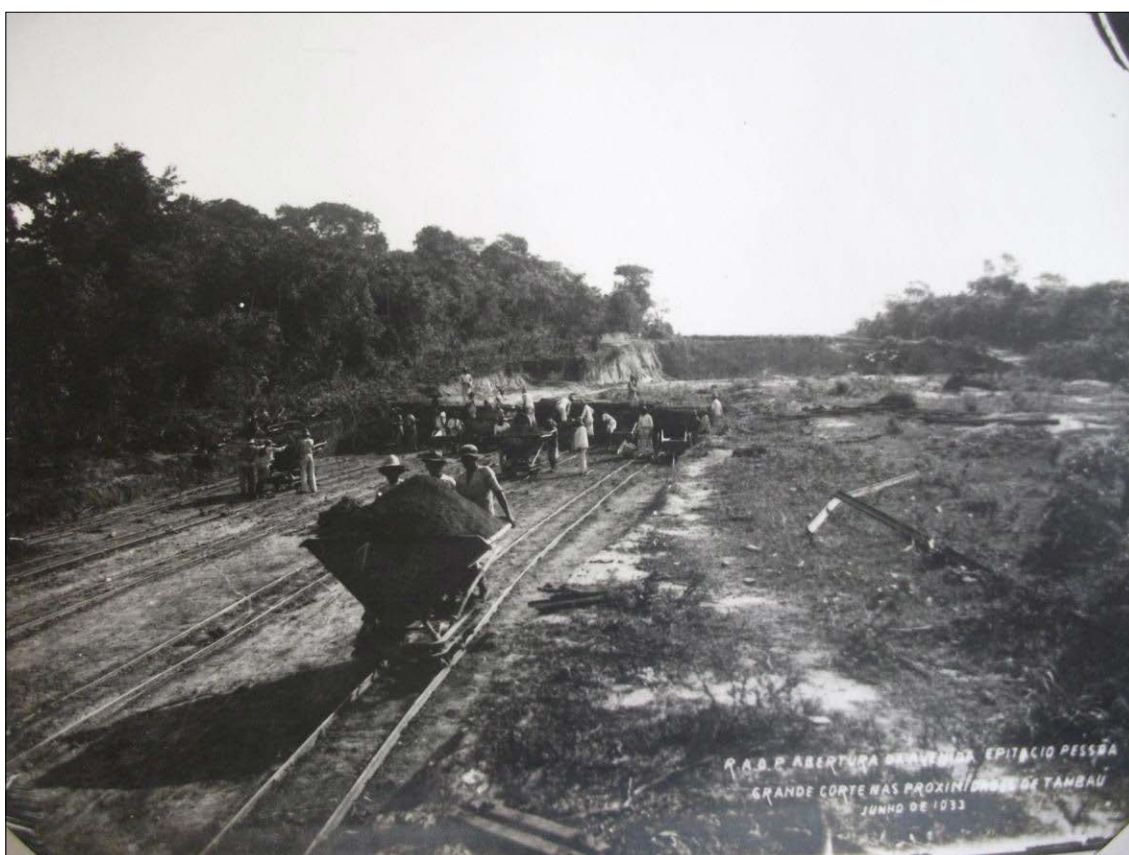
Figura 2: Abertura da Epitácio Pessoa em Junho de 1933, Grande corte nas proximidades de Tambaú.
