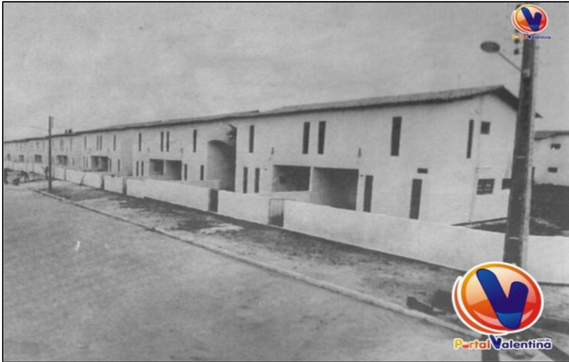
FIGURA 6 : Vista do conjunto após sua construção – unidade de duplex
