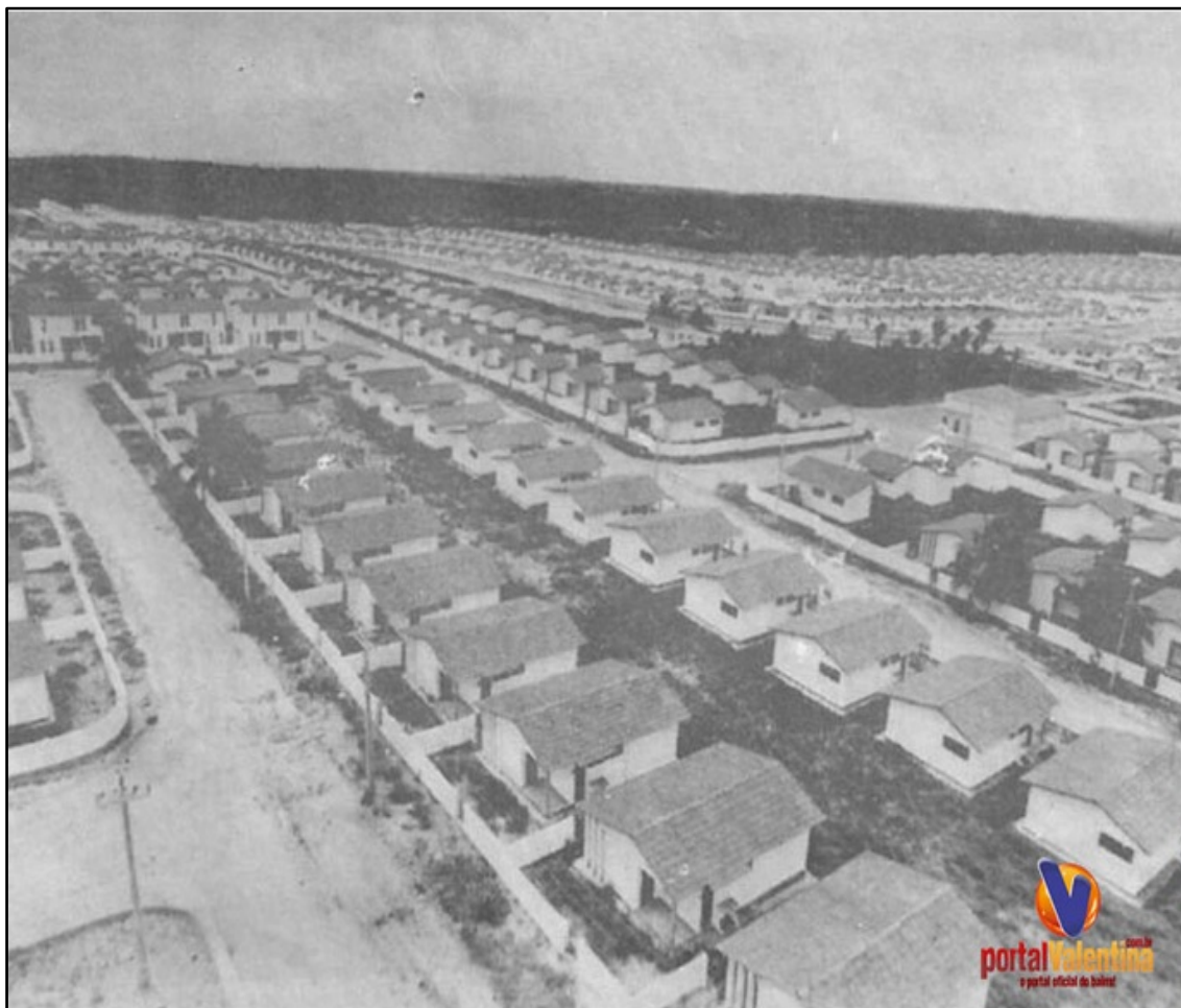
FIGURA 5: Vista aérea do conjunto após sua construção – unidades térreo
