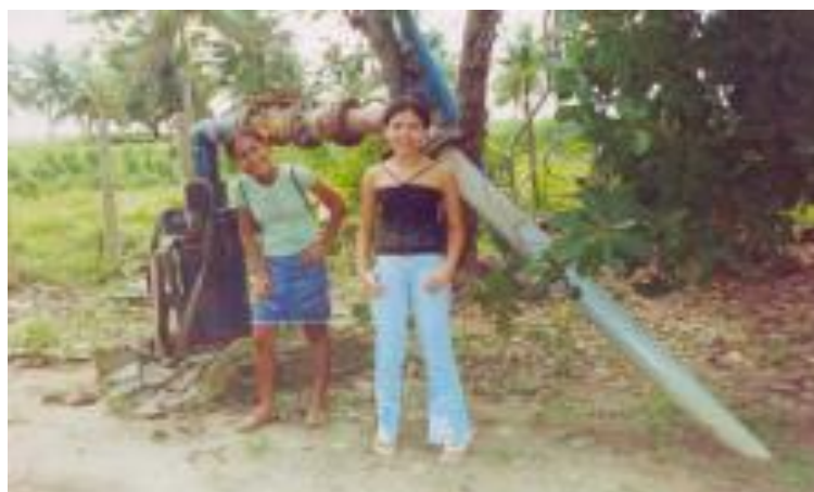
FOTO 5: Tubulação do poço que abastece a cidade de Caaporã.
