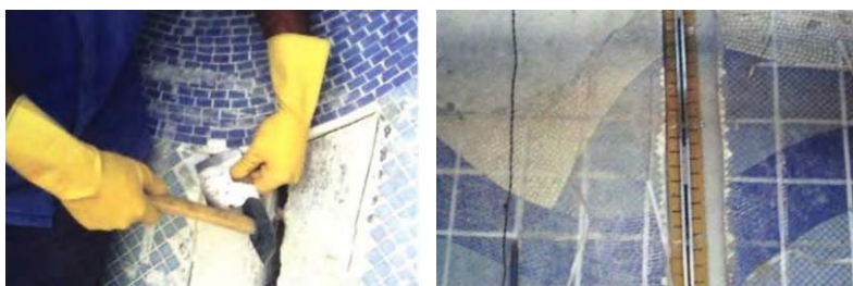
Figura 117: Abertura e tratamento da junta de dilatação, após a remoção dos revestimentos. Fonte: CASTRO; FINGUERUT, 2006, p.32.
