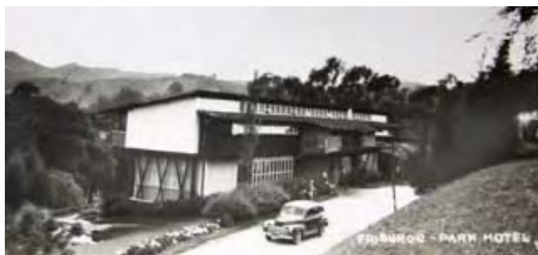
Figura 14: Parque Hotel na época da construção - Nova Friburgo, 1944. Arquiteto Lúcio Costa, projeto realizado em 1944 (Acervo Família Guinle). Fonte: GUERRA, 2008.
