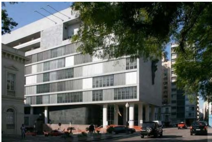
Figura 75: Palácio da Justiça de Porto Alegre após a intervenção. Foto: Abílio Guerra. Fonte: MARQUES, 2009.
