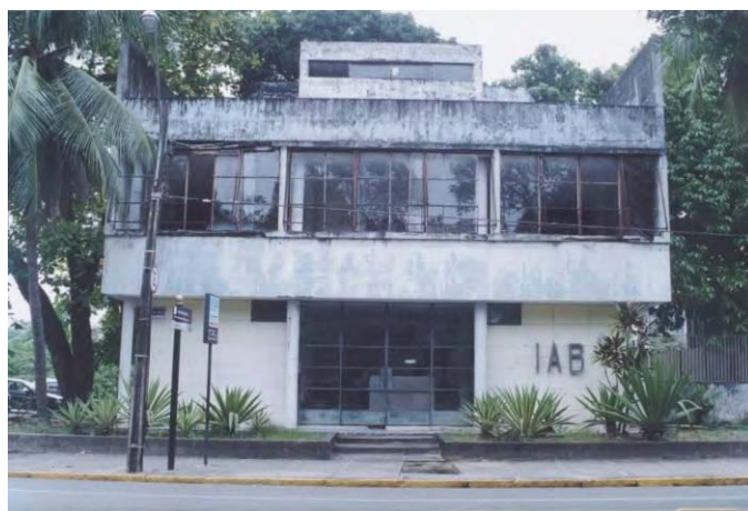
Figura 94: Pavilhão de Óbitos do Recife em 2005 (Arquivo equipe do IAB-PE). Fonte: Foto cedida pelo arquiteto Bruno Ferraz.
