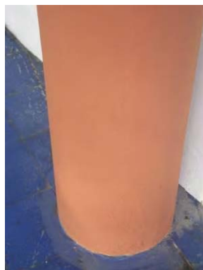
Figuras 95,96: Vistas do pilar de concreto, antes e depois da intervenção (Arquivo equipe do IAB-PE). Fonte: Fotos cedidas pelo arquiteto Bruno Ferraz.
