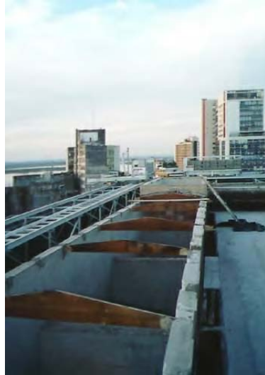
Figura 69: Foto da obra de intervenção no Palácio da Justiça de Porto Alegre. Imagem dos shafts remanescentes. Fonte: MELLO; ALVAREZ; ROSINHA, 2007.
