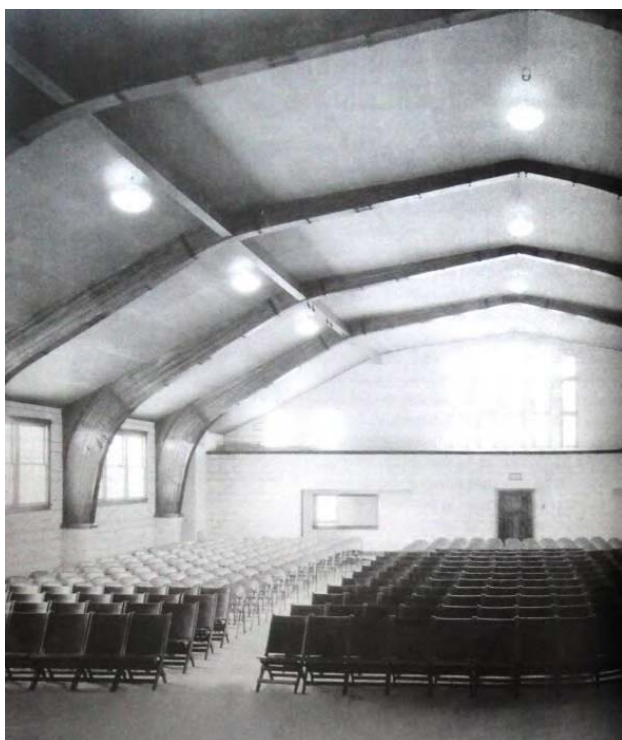
Figura 88: Vista interior do ginásio da Peshtigo High School, com estrutura em madeira laminada - Peshtigo, Wisconsin. Arquiteto Max Hanisch. Fonte: PRUDON, 2008, p.104.
