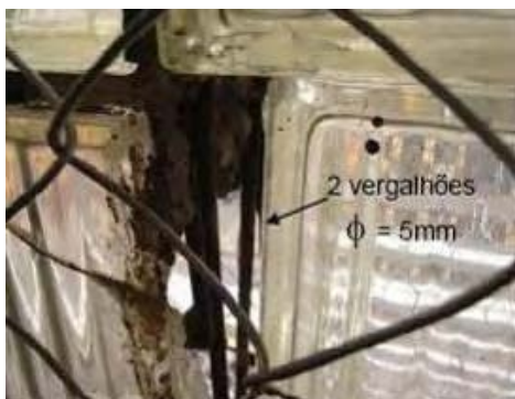
Figura 144: Detalhe da esquadria móvel que intercala os panos de blocos de vidro e a escrivaninha integrada, desenhada por Levi como apoio para os usuários do banco. Fonte: ANELLI; FERREIRA; ROSSIGNOLO. 2006.
