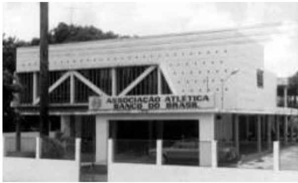
Figura 29: Sede da ABB - João Pessoa, 1987, obra executada em 1954-1957. Foto: Roberto Moita. Fonte: ROCHA, 1987, p. 60.
