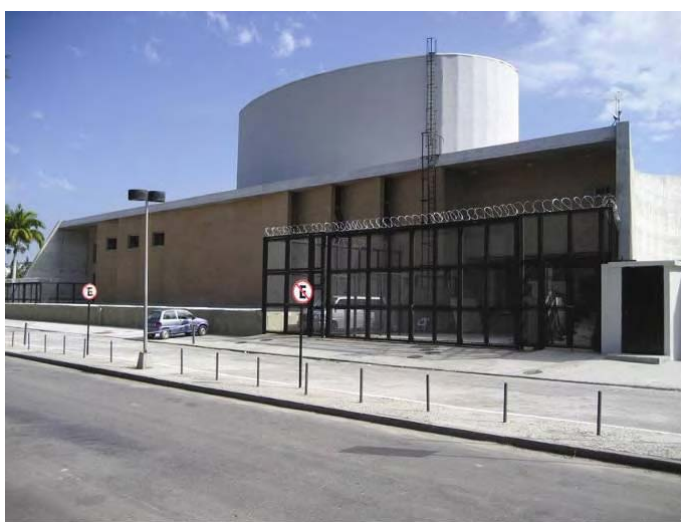
Figura 62: Vista externa do teatro do MAM, com o volume da caixa de palco revestido em placas de cimento. Foto: Roberto Segre. Fonte: SEGRE. et al, 2007.
