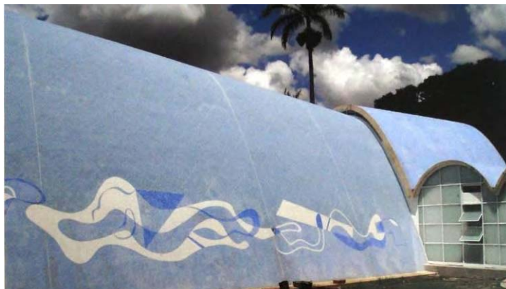
Figura 119: Obras concluídas em 2005, após o rejuntamento e a limpeza geral das pastilhas. Fonte: CASTRO; FINGUERUT, 2006, p.34.
