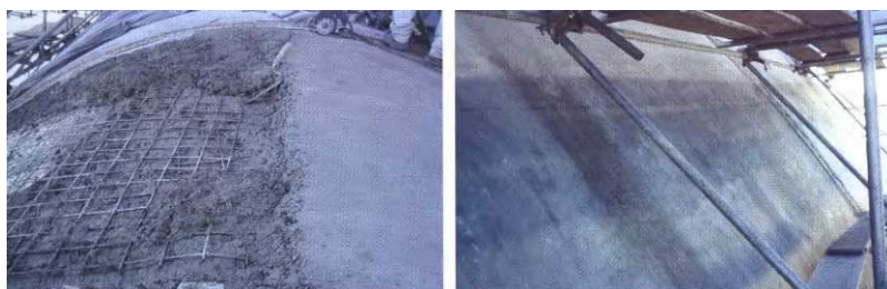
Figuras 115, 116: Reconstituição da cobertura com microcimento e aplicação de base cimentícia e cobertura da nave após a reconstituição e a regularização. Fonte: CASTRO; FINGUERUT, 2006, p.33.
