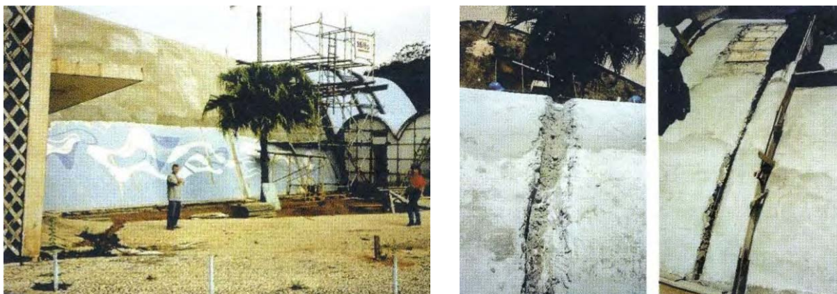
Figuras 103, 104, 105: Imagens das obras de recuperação da igreja em 1990 -1992. Na primeira foto, a retirada das pastilhas da nave central, nas duas últimas, a recuperação das juntas de dilatação (Arquivo IEPHA/MG). Fonte: CASTRO; FINGUERUT, 2006, p.21.
