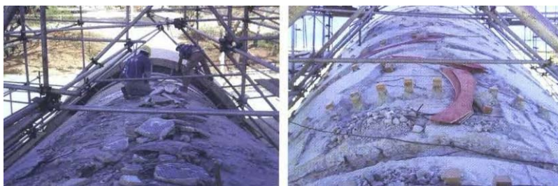
Figuras 113, 114: Demolição das camadas de nivelamento da cobertura da nave executadas na intervenção finalizada em 1992. Fonte: CASTRO; FINGUERUT, 2006, p.31.
