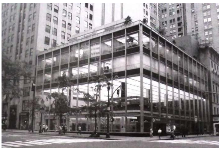
Figura 155: Vista geral do Manufactures Bank Hanover Trust Building - Nova York. Arquiteto Gordon Bunshaft, da Skidmore, Owings & Merrill, obra executada em 1951-1954. Vista após a intervenção. Fonte: PRUDON, 2008, p.39.
