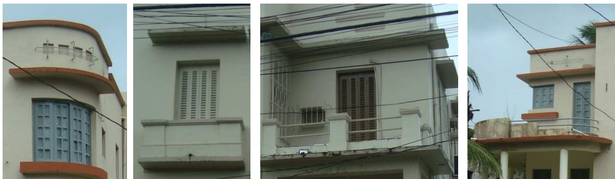
Figuras 165, 166, 167 e 168: Detalhes do uso do ferro, balcões, marquises e guarda corpo de ferro e alvenaria.
