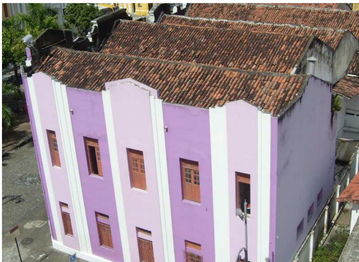
Figura 102: Platibanda que oculta telhado de duas águas em exemplares da Praça Antenor Navarro. Foto: Eliezer Rolim (Abril, 2010).
