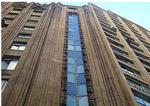
Figura 10: Edifício do Antigo Banco de São Paulo (Art Déco requintado). Fonte: CAMPOS (2003).
