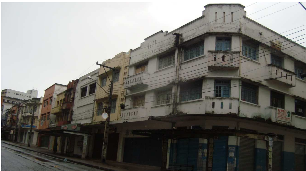
Figura 94: Avenida Guedes Pereira e a inserção dos edifícios Art Déco em um dos lados da via. É marcante a mudança na paisagem urbana com a inserção desses edifícios. Foto: Fernanda Farias (Janeiro, 2011).
