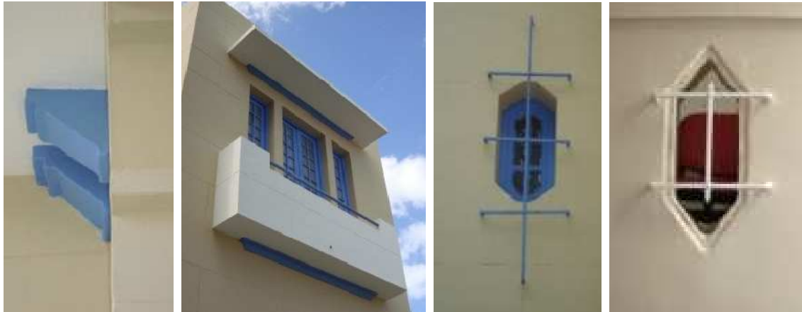
Figura 136: Detalhe das mísulas. Figura 137: Janela da edificação, balcão e marquise. Figuras 138 e 139: Elementos decorativos de ferro na fachada frontal e no corrimão da escada no interior da edificação, respectivamente.
