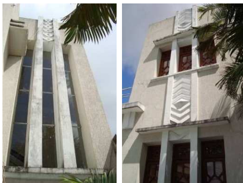
Figuras 154 e 155: Esquadria da escada, com elemento decorativo no topo da esquadria e esquadrias de madeira e vidro, com desenho geometrizado, e a presença das marquises, respectivamente. Foto: Fernanda Farias (Setembro, 2008).
