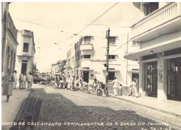
Figura 85: Serviço de calçamento complementar da Rua Barão do Triunfo em 1949. Foto: Acervo Humberto Nóbrega.
