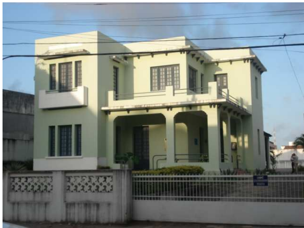
Figura 133: Foto frontal edificação. Foto: Fernanda Farias (Setembro, 2008).
