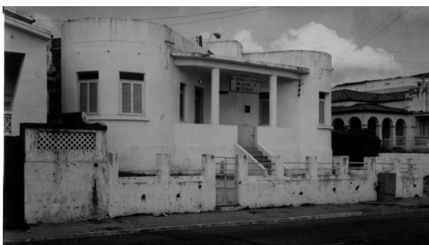
Figura 36: Fotografia da edificação nº 849, quando a mesma ainda preservava o muro e a escadinha de entrada frontal.
