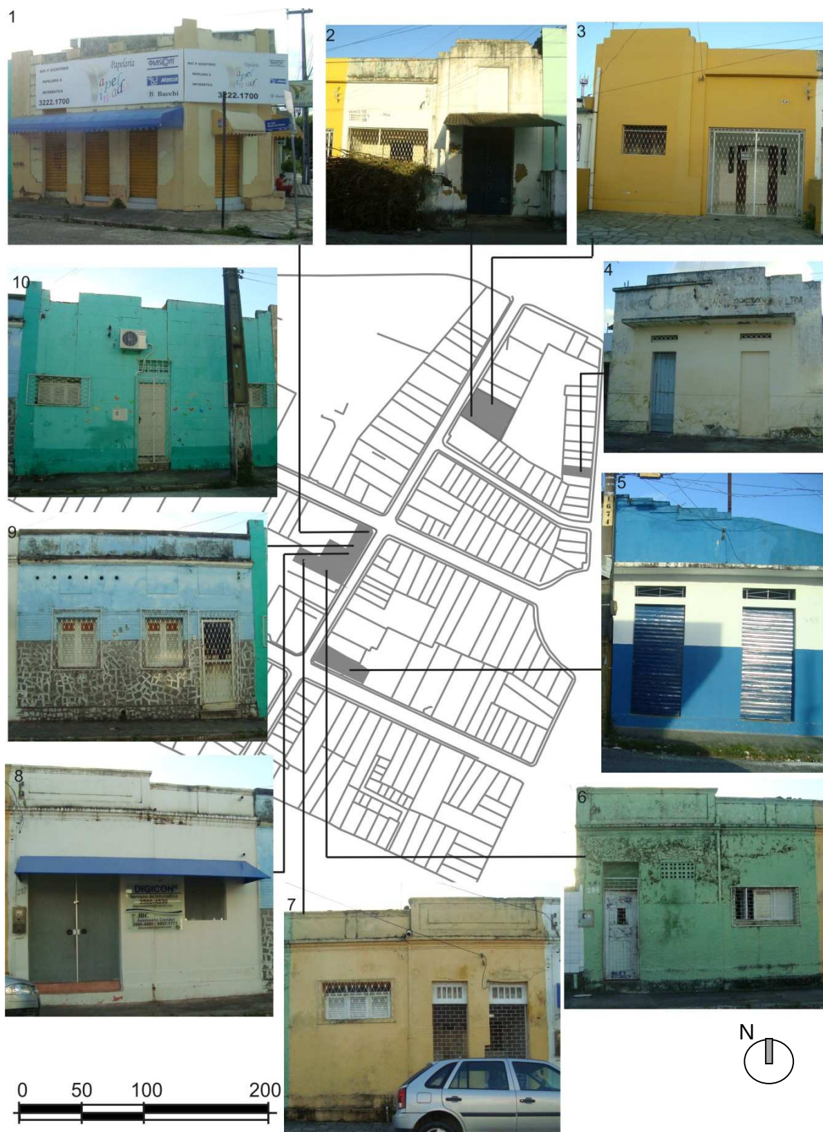
Figura 176: Trecho do Bairro da Torre com exemplares Art Déco da Rua Bento da Gama. Fonte: PMJP editado por Fernanda Farias.
