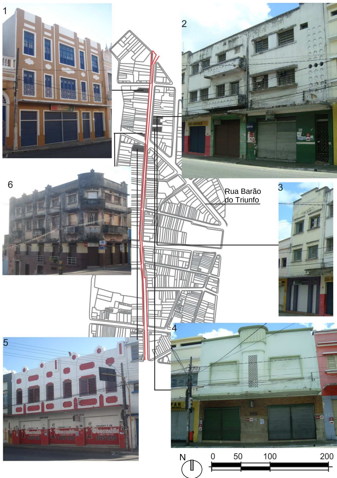
Figura 75: Trecho da Cidade Baixa com exemplares Art Déco da Rua Maciel Pinheiro. Destaca-se em vermelho o traçado urbano antes do alargamento de um dos lados da rua. Fonte: PMJP editado por Fernanda Farias.
