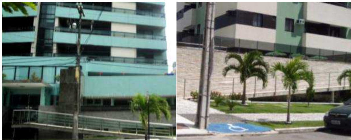
FIGURA 56. Edificações (quarteirões C e D respectivamente) com destaque para rampas de acesso. FONTE: SILVEIRA (2011).
