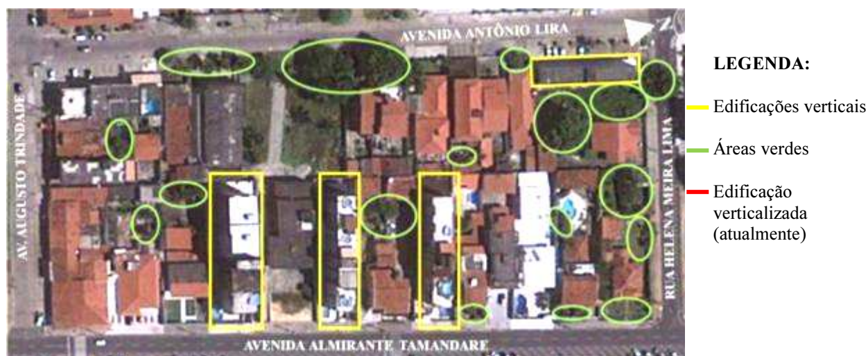
FIGURA 66. Vista aérea do quarteirão A com delimitação de áreas verdes e edificações verticalizadas. FONTE: GOOGLE EARTH, editado pela autora.
