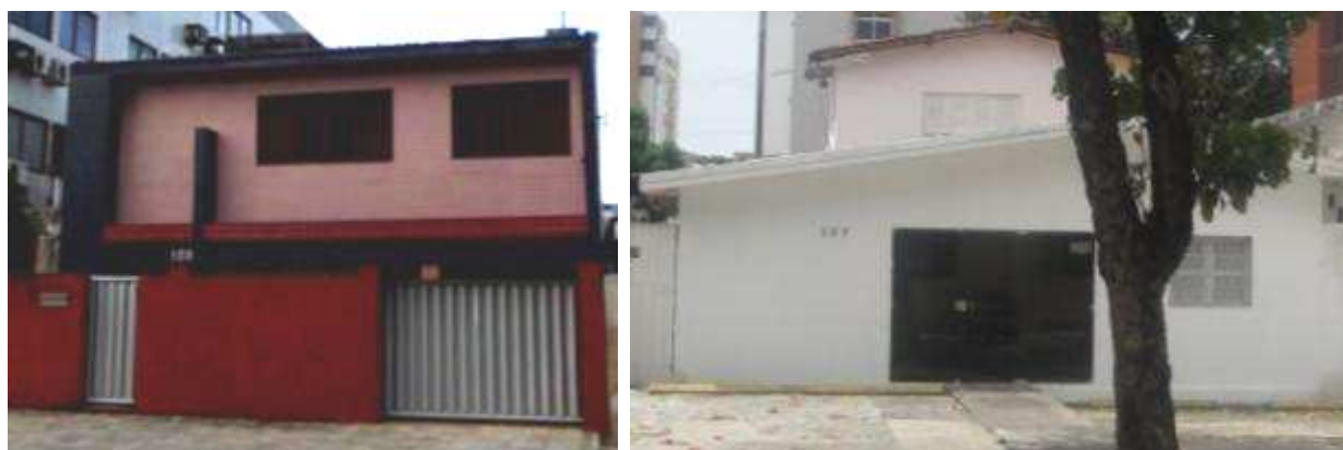
FIGURA 54. Edificações unifamiliares (quarteirão B e C, respectivamente) FONTE: SILVEIRA (2011).
