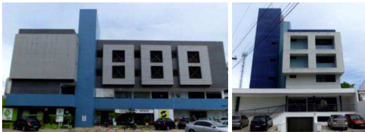
FIGURA 41. Edifícios empresariais voltados para a Av. N a S a dos Navegantes (quarteirão B) FONTE: SILVEIRA (2011).
