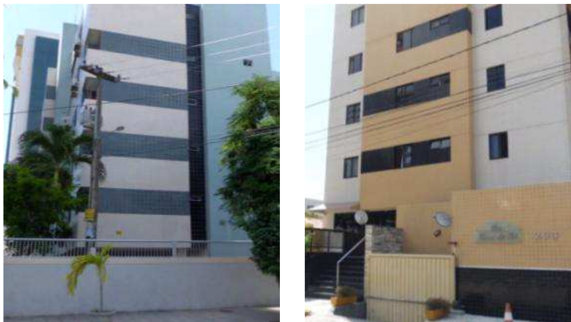
FIGURA 57. Edificações (quarteirão C e D respectivamente), com destaque para a fachada frontal voltada para o poente, sem grandes aberturas. FONTE: SILVEIRA (2011).
