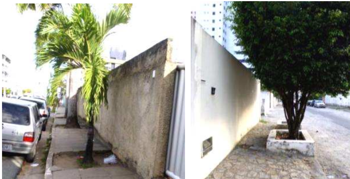
FIGURA 83. Passeios estreitos com vegetações instaladas de maneira inadequada (quarteirões B e D, respectivamente).
