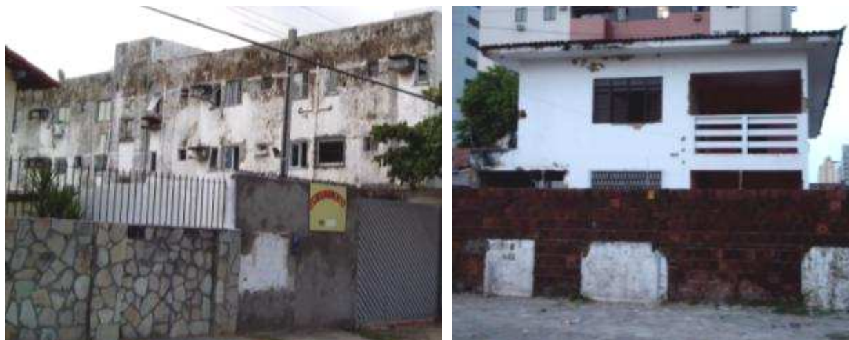
FIGURA 37. Vista dos fundos de edificação multifamiliar (quarteirão A) e edificação unifamiliar (quarteirão D). FONTE: SILVEIRA (2011)
