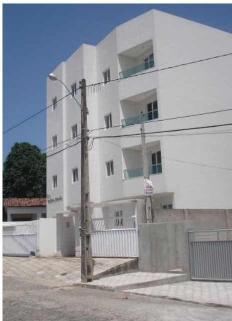
Figura 40: Edifício como marco visual na periferia da comunidade. Fonte: Ana Luzia Pita, 2011.
