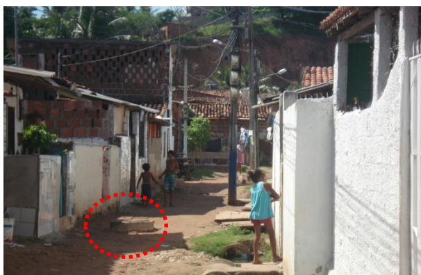
Figura 03: Domicílios não possuem calçadas e avançam no limite da rua. “Boca de lobo” elevada dificulta mobilidade. Fonte: Ana Luzia Pita, 2012.
