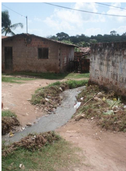
Figura 31: Ruas do Timbó sem infraestrutura e casas simples representam o espaço da cidade ilegal.
