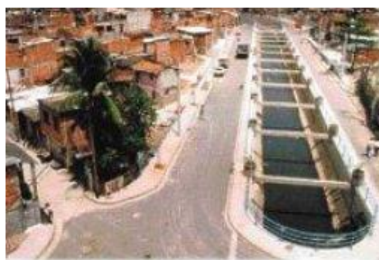
Figura 7: Canalização do Rio.
