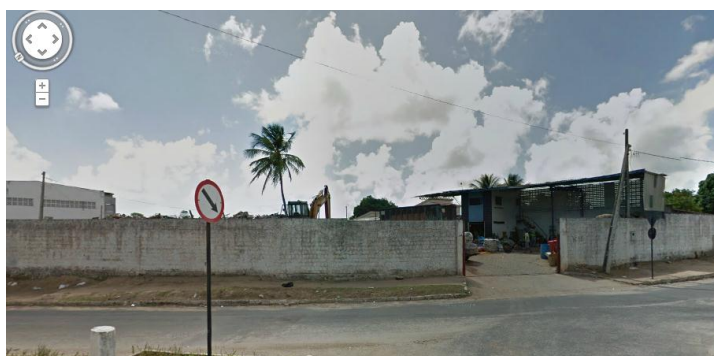
Figura 42: Área destinada ao abrigo temporário de lixo. Fonte: Google Earth, 2012.
