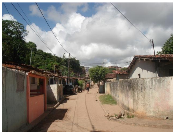
Figura 06: A Rua Rosa Lima dos Santos é uma das que apresenta melhor infraestrutura.
