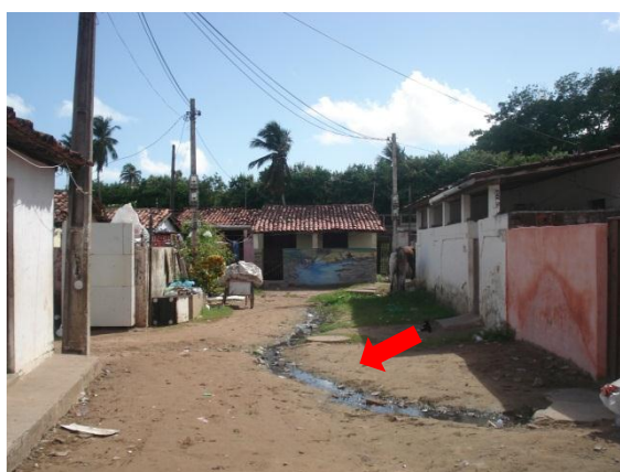
Figura 05: Esgoto escorrendo pela rua.
