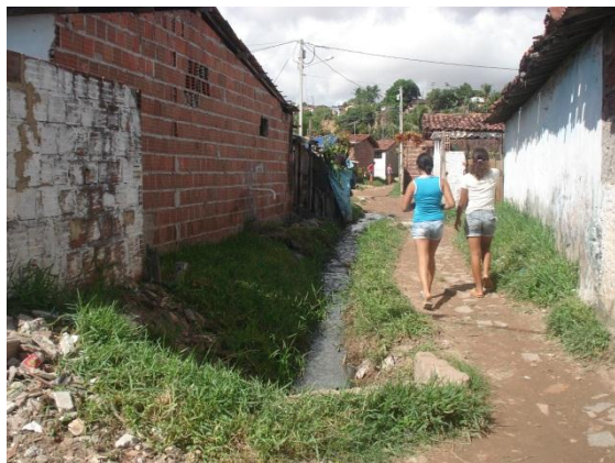
Figura 01: Rua estreita apresentando grande abertura para passagem de esgoto. Fonte: Ana Luzia Pita, 2012.
