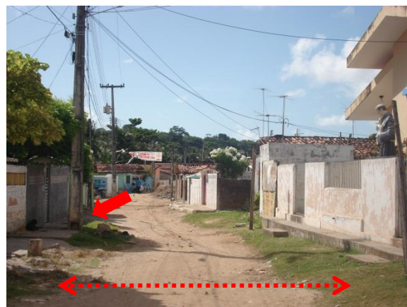
Figura 02: Sensação de alargamento da via. Calçadas desniveladas com poste inserido.
