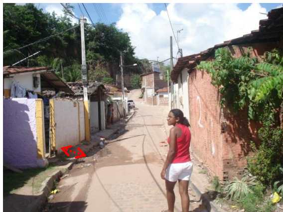
Figura 07: Trecho da Rosa Lima dos Santos onde as calçadas são muito estreitas.
