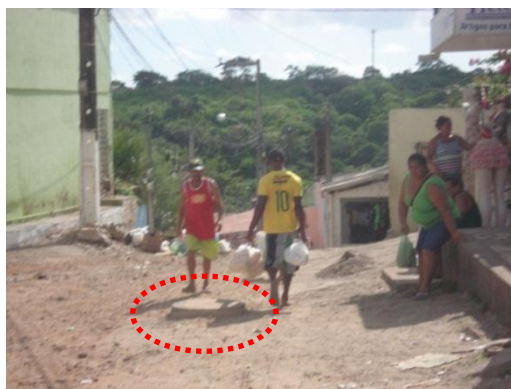
Figura 02: “Boca de lobo” elevada. Fonte: Ana Luzia Pita, 2012.
