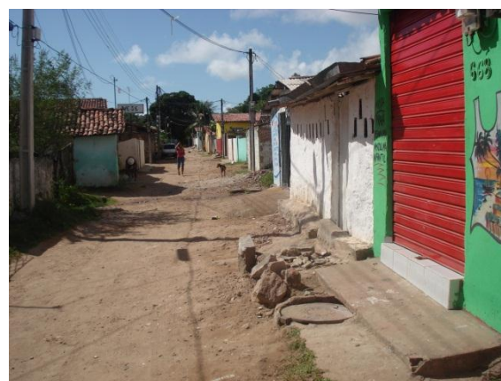
Figura 04: “Boca de lobo” na frente da calçada.
