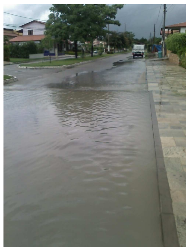
Figura 109: Rua principal alagada pelas chuvas. Fonte: arquivo Pessoal. Maio/2009
