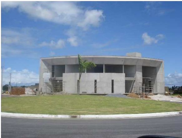
Figura 66: Residência em construção no Condomínio Bosque das Orquídeas. Fonte: arquivo pessoal. Abril/2010.
