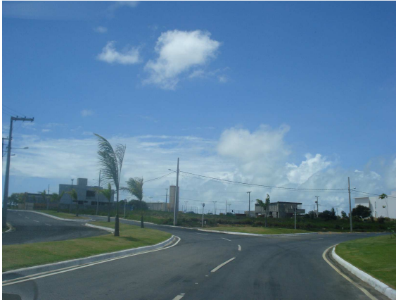
Figura 53: Ruas do interior do condomínio inteiramente asfaltadas. Fonte: Arquivo Pessoal. Julho/ 2011.
