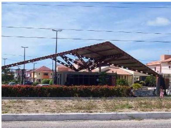
Figura 21: Vista da portaria do Condomínio. Fonte: www.cabobrancoprive.com.br - Julho/2009.
