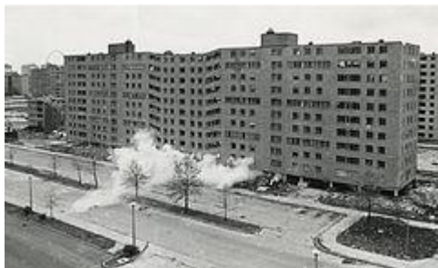
Figura 15 – A demolição do complexo de Pruitt-Igoe em 1972.
