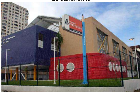
Fotografia 2.6 - Escola Municipal Tia Ciata, Rio de Janeiro/RJ
