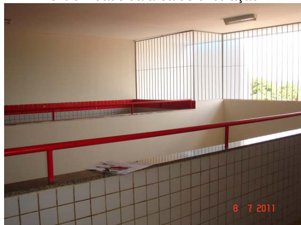
Fotografia 4.24 – Abertura lateral na extremidade da área de circulação
