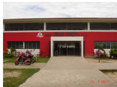
Fotografia 4.8 - Terreno plano da E. M. Afonso Pereira
