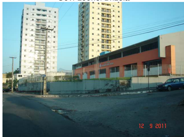
Fotografia 4.19 - Entorno obstruído da E. M. Gov. Leonel Brizola
