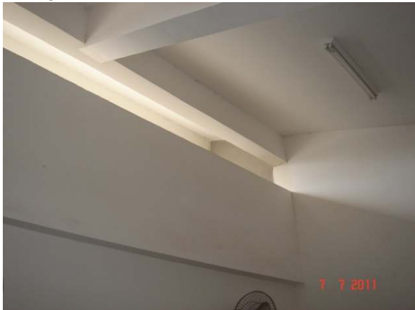
Fotografia 4.21 – Clerestório existente nas salas
