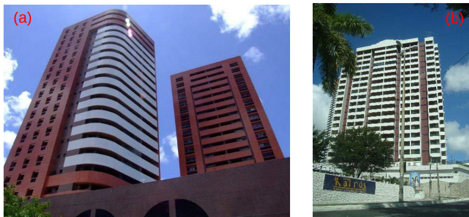
Figuras 83 e 84: Imagens do Edifício Reinos de Espanha (a) e do Edifício Riviera (b), construídos no Trecho 6 na década de 1990. Fonte: Acervo da autora (2014).
