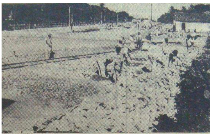
Figura 10: Imagem da obra de calçamento da Avenida Epitácio Pessoa. Fonte: A União (8 nov. 1952).
