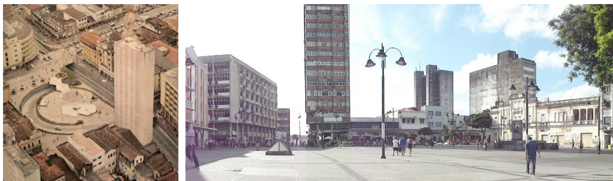
Figura 48, 49: Vista aérea do Ponto de Cem Réis, 1974. Vista panorâmica do Ponto de Cem Réis, 2014. Fonte: Revista Manchete. Acessada em 03.02.2014. < http://centrohistoricojp.blogspot.com >. E Marcela Dimenstein, Jan.14.
