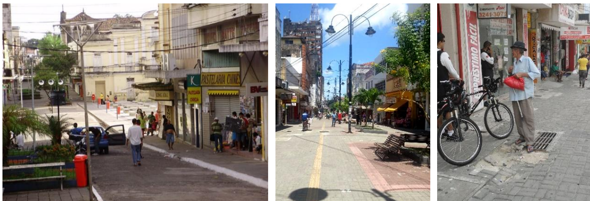
Figura 45, 46, 47: Rua Duque de Caxias em 2009, antes da reforma. Em 2013, depois da reforma e em 2014 apontando danos já sofridos pelo piso. Fonte: Site Portal da cidade de João Pessoa. Acessado em 03.02.2014 < http://paraibanos.com/joaopessoa/fotos-antigas.htm >. E Marcela Dimenstein, Jun.13, Jan.14.
