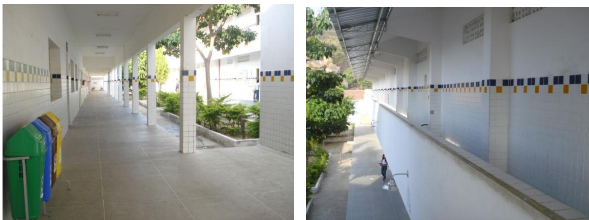
Figura 41: Corredor piso inferior e corredor piso superior da EEEFM Profº José Gonçalves Foto: Líbna Naftali, 2011.
