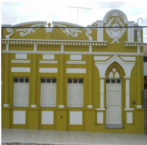
Figura 5: Fachada do casarão da família Mayer Foto: Líbna Naftali, 2011.
