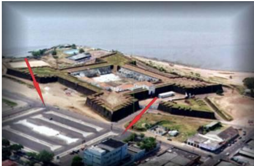
Imagem 13: Estacionamento e Instituição bancária.
