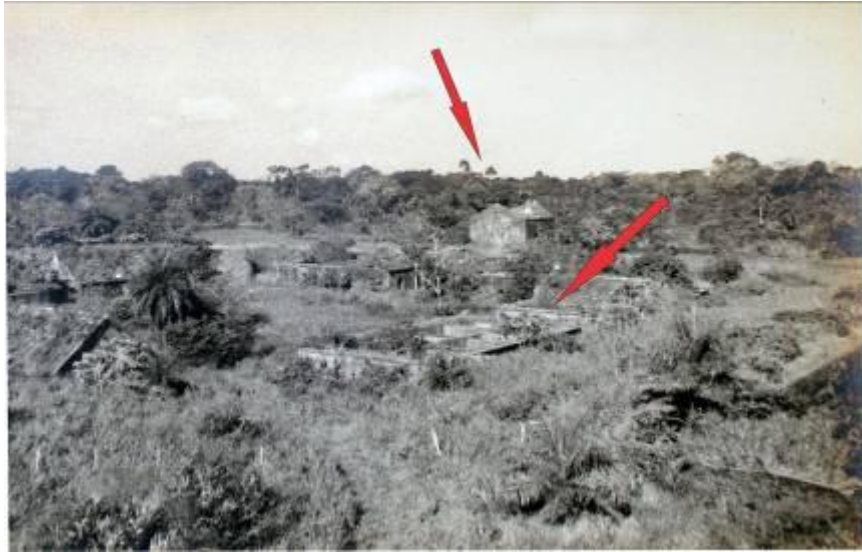
Imagem 12: Vegetação e árvores frondosas; deteriorações por abandono dos telhados originais.
