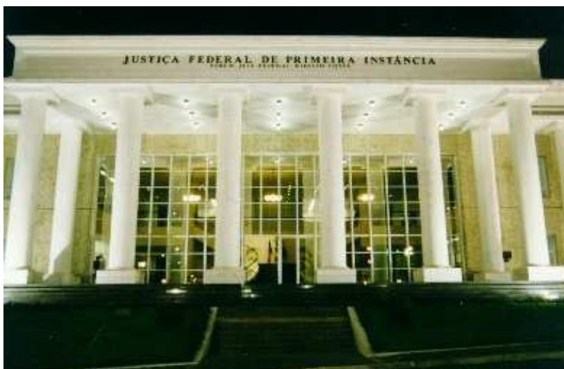
Figura 3 - Fachada do edifício sede da JFPB em João Pessoa – PB
