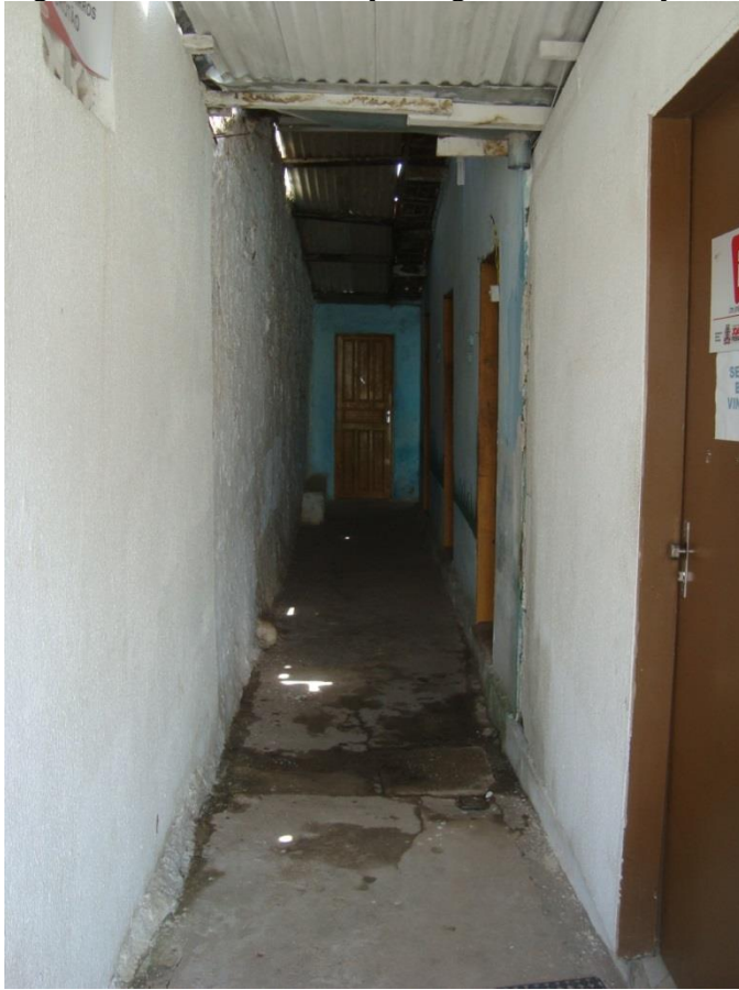
Figura 12 – Entrada da Estação Digital na Associação de Moradores
