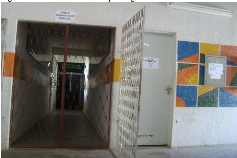
Figura 10 – Infraestrutura das Estações Digitais – Casa Brasil
