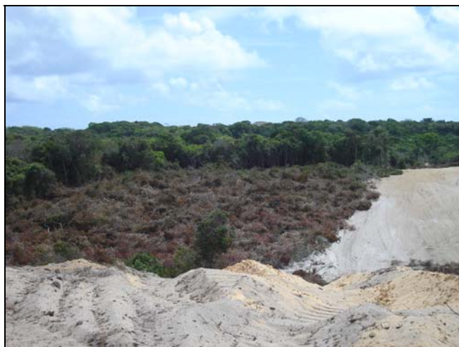
Figura 3 - Fase de desmatamento. Retirada da vegetação com uso de moto-serra e foices (a esquerda), uma área onde já houve a retirada da matéria orgânica utilizando máquinas pesadas (a direita) (Foto: Rodrigo Alberto).
