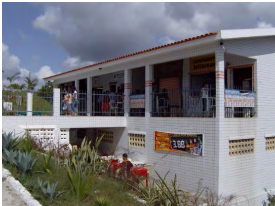
Figura 5: Prédio onde se localizam duas lojas, uma lanchonete, posto de saúde e banheiros na parte inferior, por trás da estrutura. Fonte: Arquivo do autor, dezembro de 2006.
