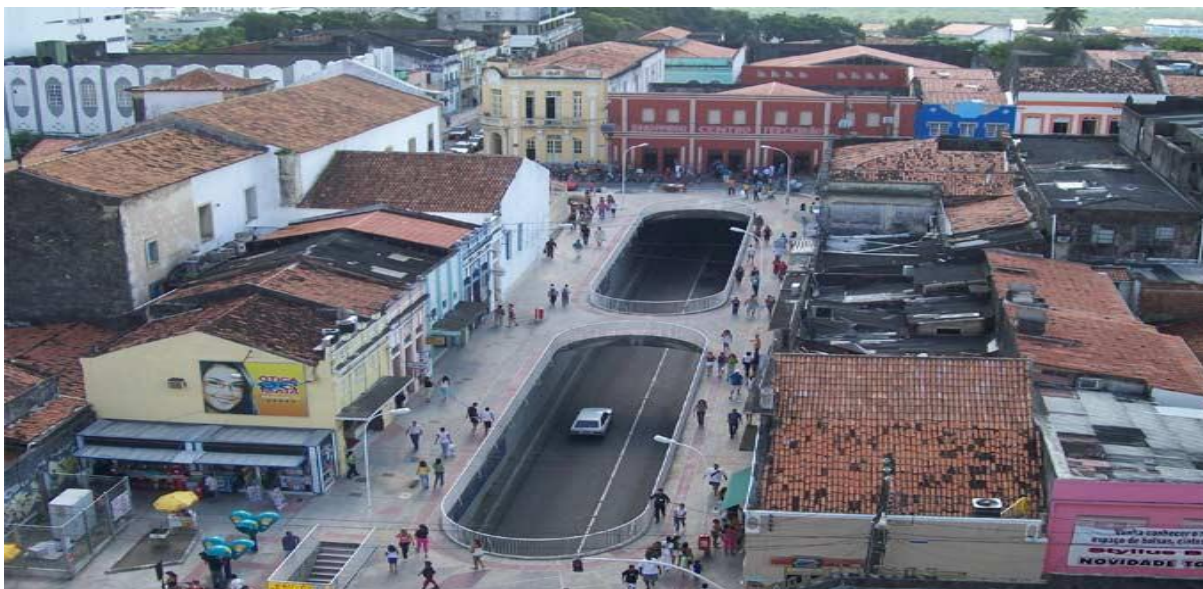
Figura 2 – Vista panorâmica do SCT
