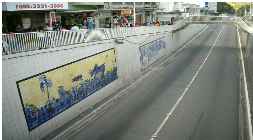
Figura 1 – Viaduto sobre o qual foi construído o Shopping
