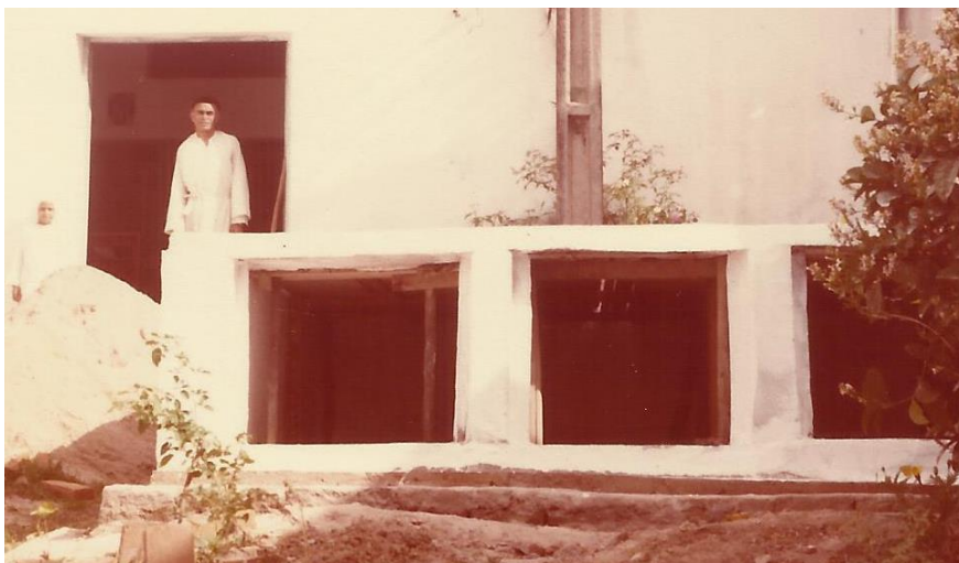
Figura 32 – Um dos seguidores do movimento ao fundo e a obra de construção dos túmulos na década de 80. 64
