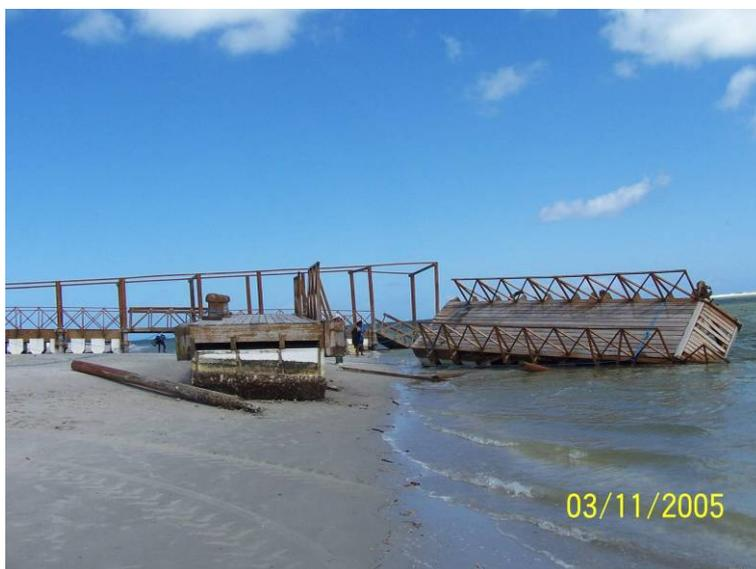
**FIGURA 28** - ANCORADOURO CONSTRUÍDO PELO PROJETO CIRCUITO NÁUTICO DO LITORAL NORTE – PE DESTRUÍDO PELA AÇÃO DO MAR - PRAIA DE ORANGE - ILHA DE ITAMARACÁ. **DATA:** novembro/2005
