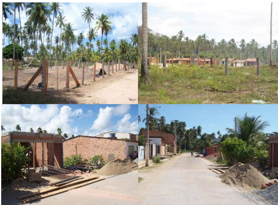
Figura 29: Construção de casas em São Miguel dos Milagres, 2012 Fotos do autor.
