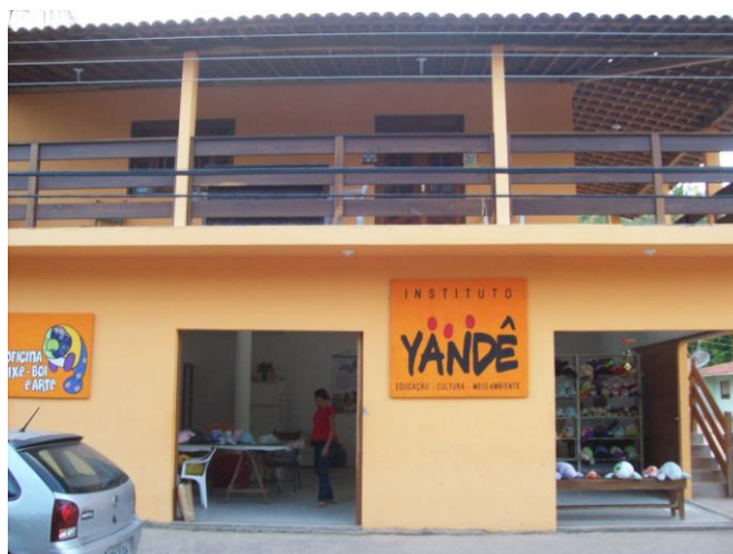
Figura 24: Sede do Instituto Yandê. São Miguel dos Milagres, 2012 Foto do autor
