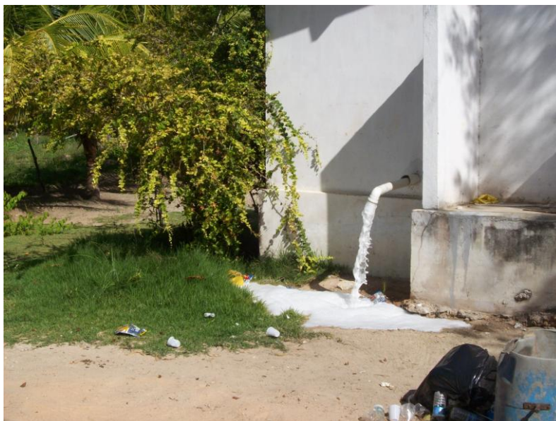
Figura 32: Despejo inadequado de águas residuais em São Miguel dos Milagres, 2012 Foto do autor
