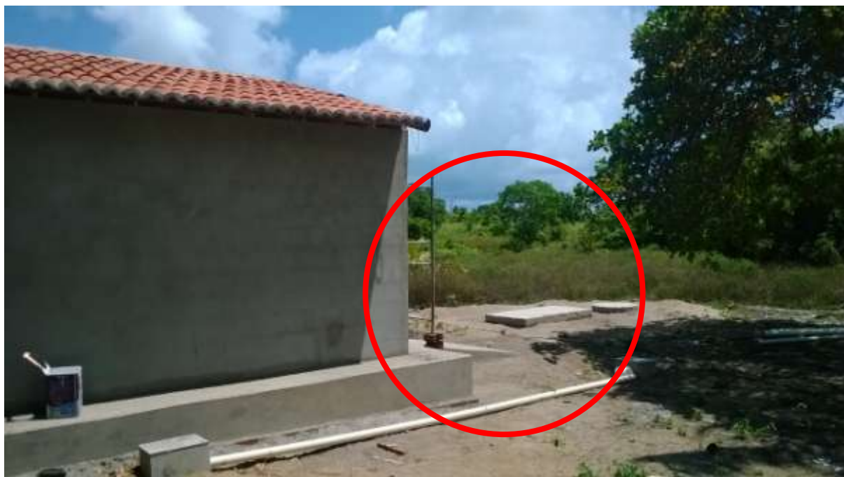
FIGURA 12 - CASA DE ALVENARIA. NO DETALHE A RAMPA DE ACESSIBILIDADE E AS FOSSAS PARA SANEAMENTO. FOTO: SOARES, R. L. 2013
