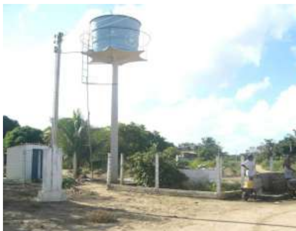
FIGURA 13 - CAIXA D'ÁGUA FONTE: GEOCONSULT, 2007
