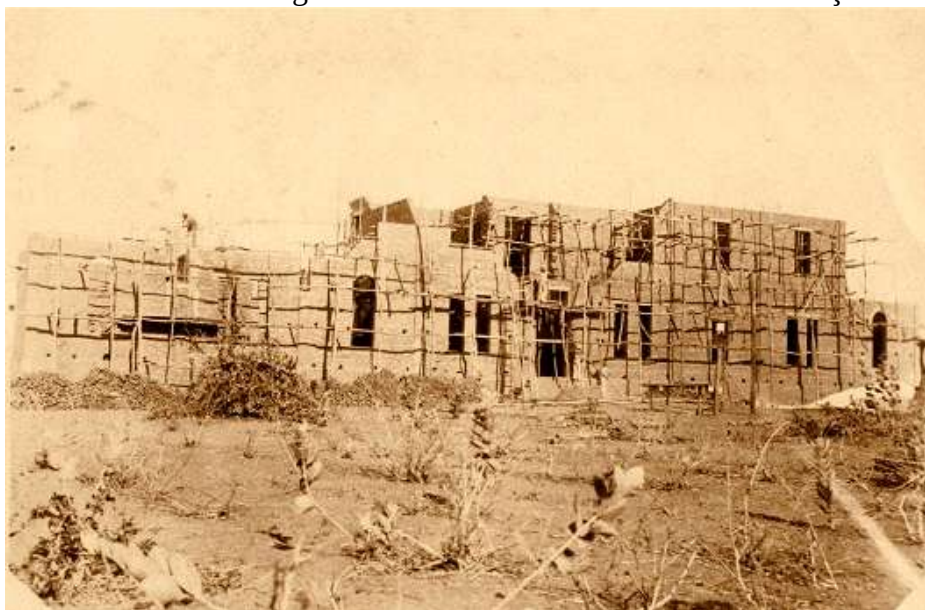
FIGURA 4- Colégio Normal Francisca Mendes em construção
