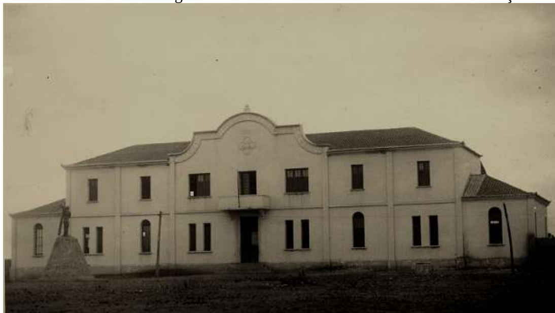
FIGURA 6 - Colégio Normal Francisca Mendes: concluída a construção
