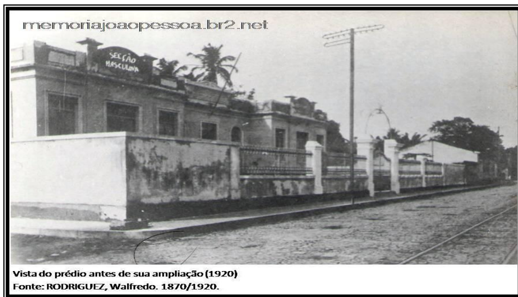
Figura 12: Grupo Escolar Eptácio Pessoa antes da ampliação 1870/1920
