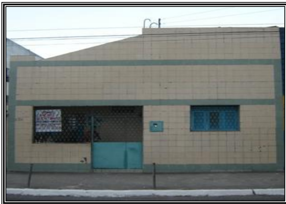
Figura 8: Casa atual onde residiu Argentina Pereira Gomes e Carmelita Pereira Gomes, localizada na Av. João Machado, 121, centro, João Pessoa-PB.
