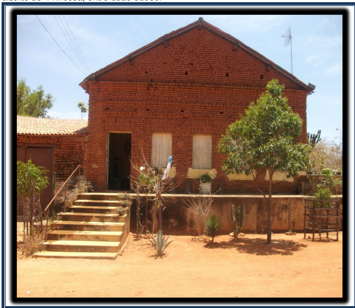
Figura 2 - Casa onde funcionou uma escola isolada mantida pelo estado em São José, distrito de Princesa, entre 1920 e 1930.
