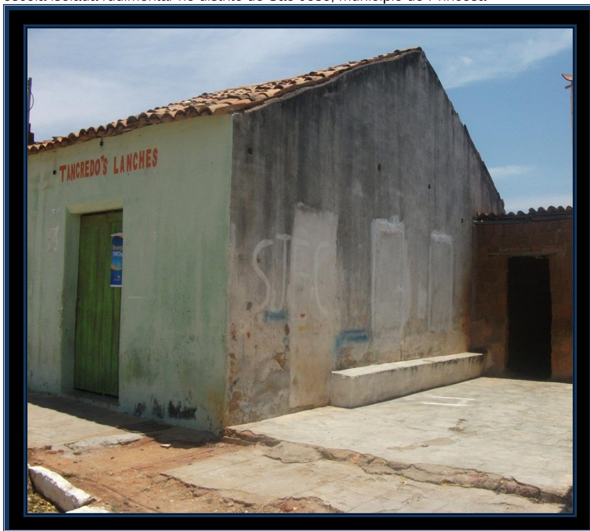
Figura 4 - Visão lateral do prédio construído no final da década de 1930, que serviu de escola isolada rudimentar no distrito de São José, município de Princesa
