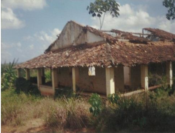
Figura 17 - Antiga casa do engenho do PA Novo Salvador
