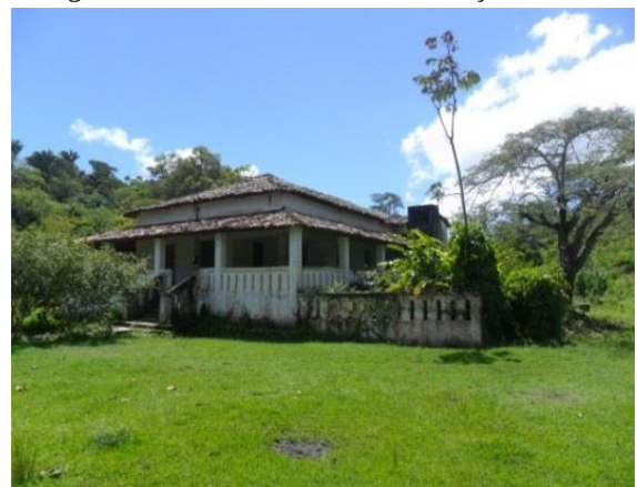
Figura 25 – Casa Sede do PA Redenção
