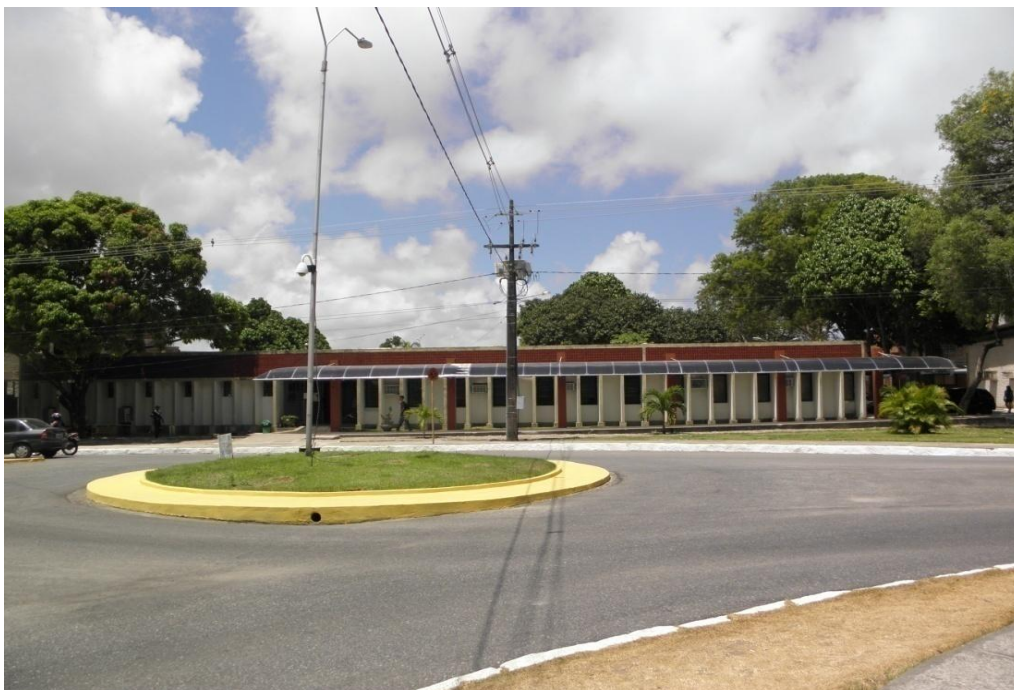
Foto 46: Aspecto panorâmico do prédio onde hoje funciona o Departamento de Música da UFPB, no Campus I.
