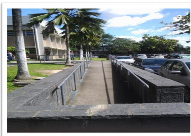
Foto 4 - Rampa de acesso ao bloco F do IFPE/Campus Recife
