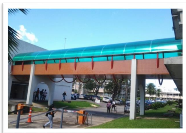
Foto 6 - Passarela de acesso aos blocos A, B, C, D e F do IFPE/Campus Recife
