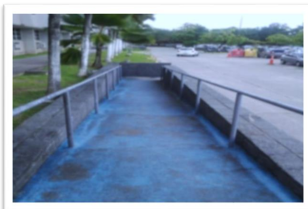
Foto 3 - Rampa de acesso para pessoas com deficiência física
