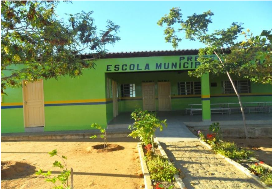
Figura 8 - Nome atual da escola na fachada central do prédio
