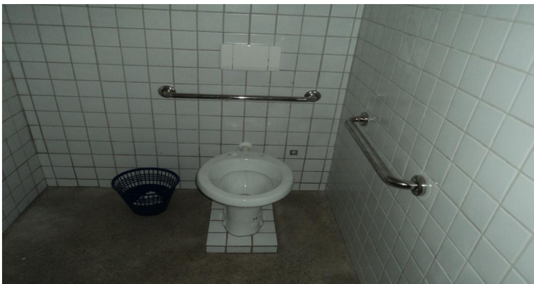
Foto 3 PPGE/CE: Banheiro Adaptado com barras
