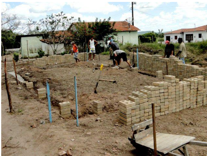
Foto 09: Trabalho em Mutirão - Construção da sede da Associação dos Trabalhadores Rurais - Comunidade Uruçu - Gurinhém – PB. Arquivo – SPM NE (Darcy Lima)
