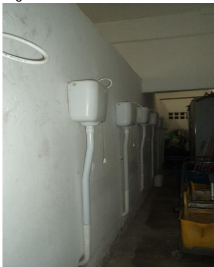
Figura 25 – Corredor das descargas dos banheiros
