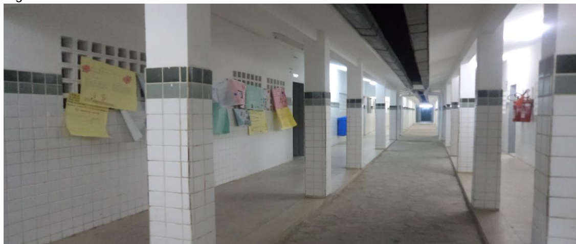
Figura 14 – Corredor entre salas de aula
