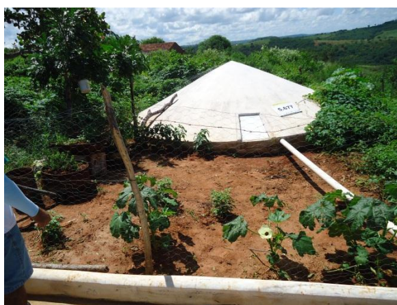
Imagem 12 - Cisternas construídas na comunidade
