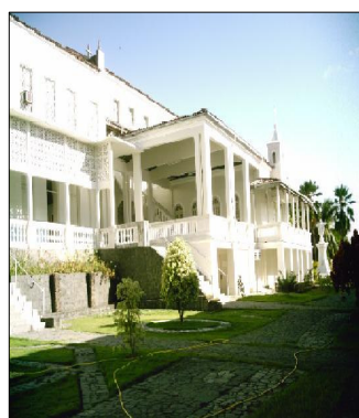
Foto 55: Continuação da fachada esquerda.
