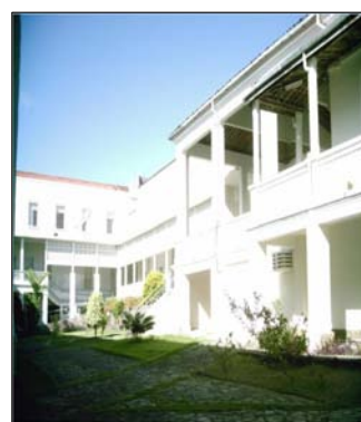
Foto 56: Continuação da fachada esquerda.
