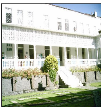
Foto 54: Fachada lateral interna esquerda.
