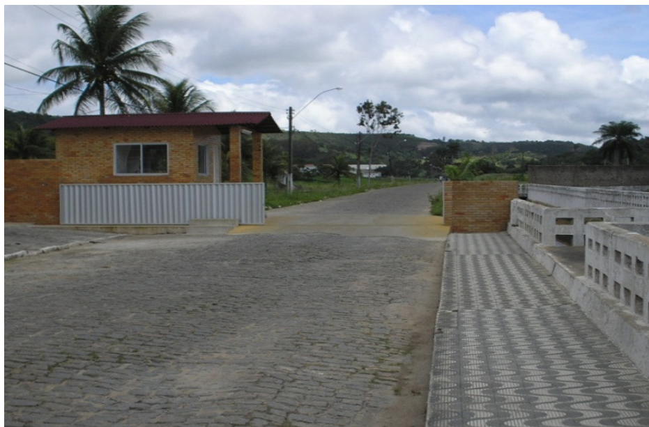
Figura 02 - Entrada do Campus III da UFPB – Bananeiras. Fonte: CCHSA.
