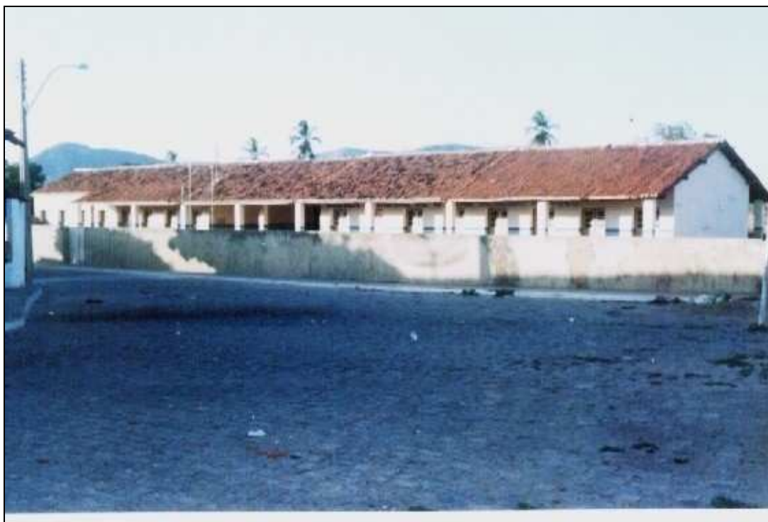
FOTO 2 – Prédio do Grupo Escolar Genésio Araújo, hoje, Escola Estadual de Ensino Fundamental Genésio Araújo, em São José da Lagoa Tapada - PB. (Acervo Particular)
